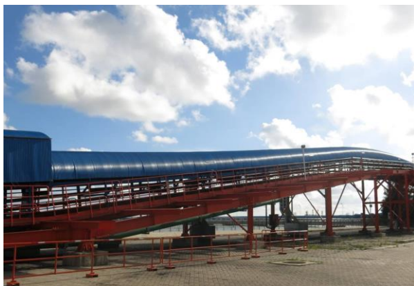
新建皮带机全封闭防尘罩
