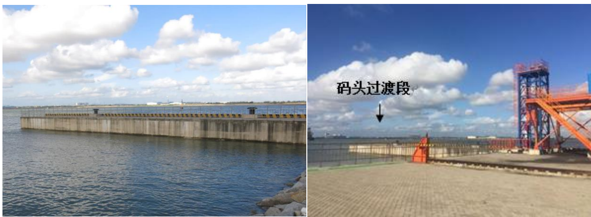
图 2.3-1 码头过渡段现场照片
