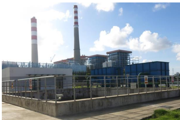
码头前方含尘污水处理站
