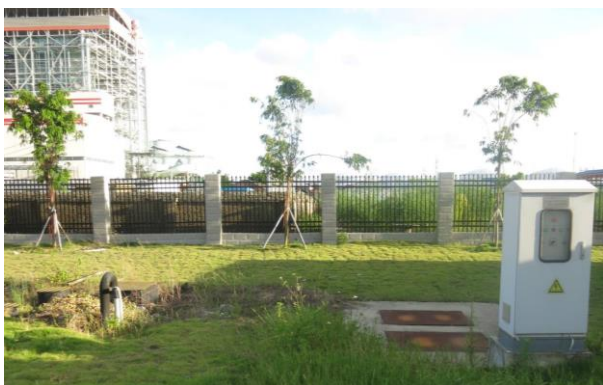
辅建区生活污水处理站
