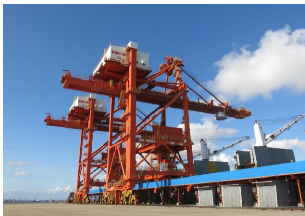
5万吨级码头前沿皮带机挡板
